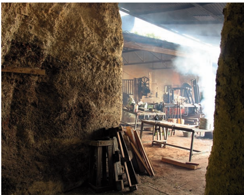
Tomas de la fachada actual del conjunto. Industria de serrería que se desarrolla en el interior del recinto.
