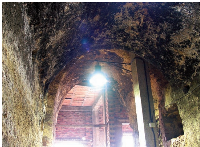
Vista interior de la Cueva 2 (Iglesia) con techo a tres alturas. Hendiduras en la piedra para agarrar de cancelas. Detalle de la cubierta simulada a dos aguas y presbiterio al fondo. Vista hacia el exterior, y, sobre estas líneas detalle de obra posterior.
